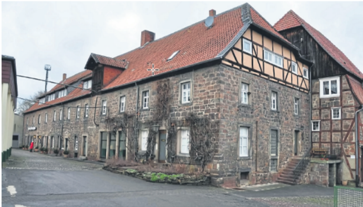
Eines der ältesten Gebäude der Stadt: Hotelkaufmann Alexander Fitz will das traditionsreiche Unternehmen mit Brauerei zu neuer Blüte bringen. Die Kellergewölbe aus dem 15. Jahrhundert könnten zu Gasträumen werden. FOTO: HASS
